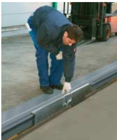
Zvednutí přemostění BB z vodící lišty.
